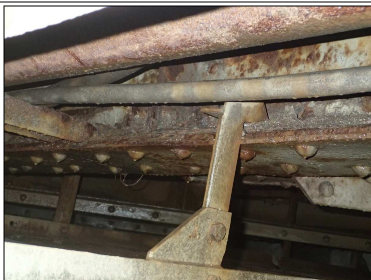
Foto č. 6 – konstrukce K 06 – horní plocha dolní pásnice hlavního nosníku vlevo – plátková koroze
