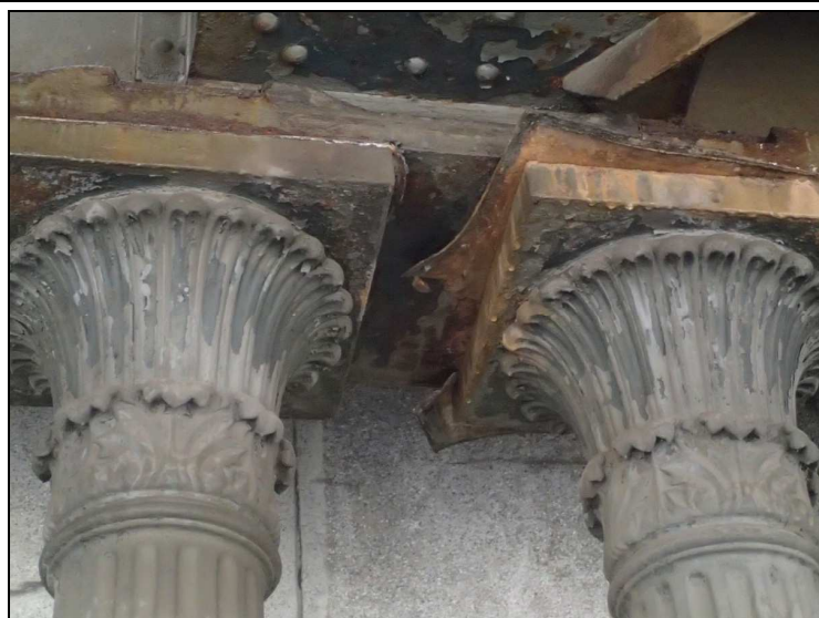
Foto č. 4 – konstrukce K 04 – ložisko nad P 04 vpravo – vymačkaná olověná podložka
