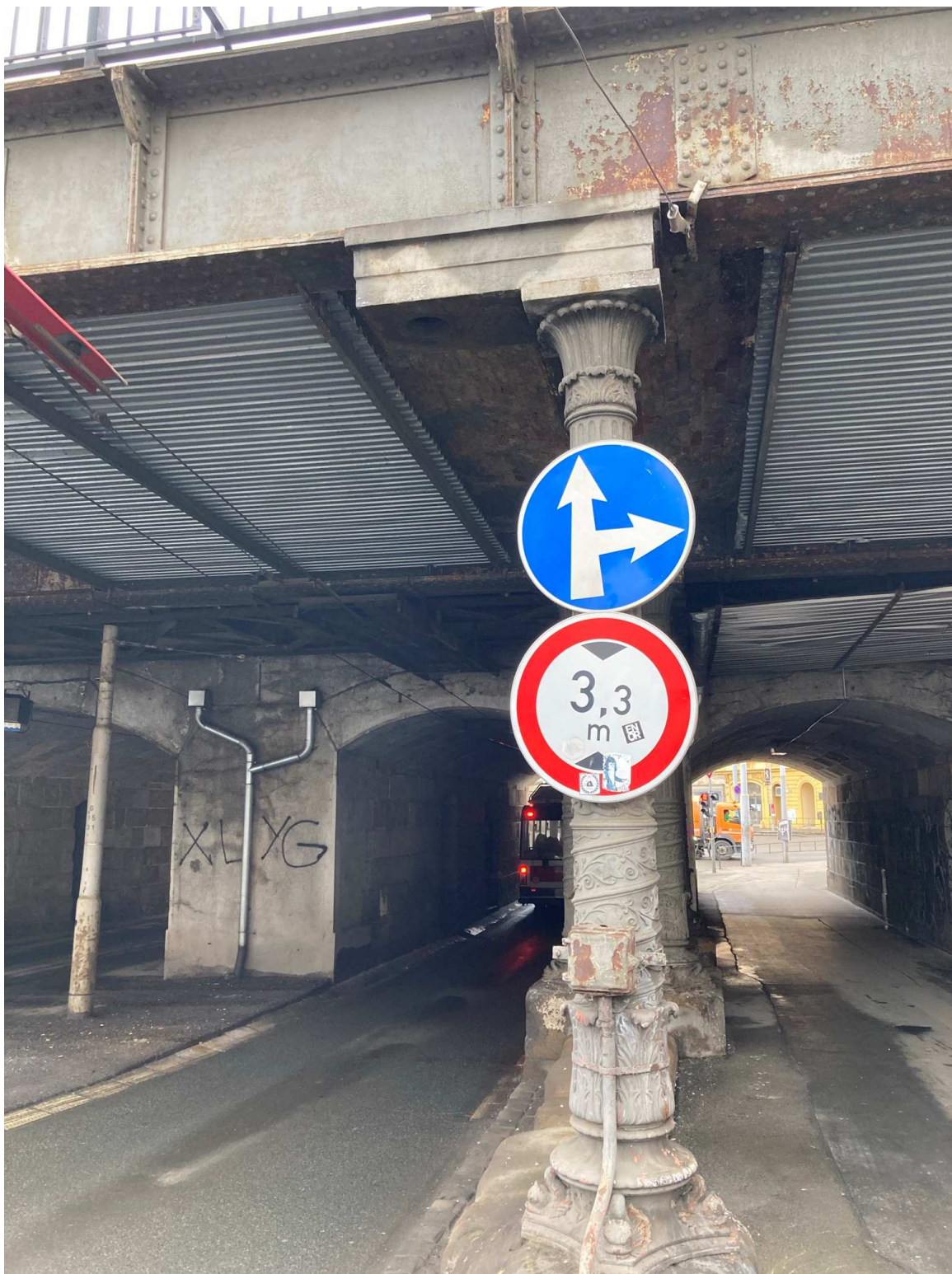
Obrázek 11 Pohled na pilíř P01 – chybějící sloup
