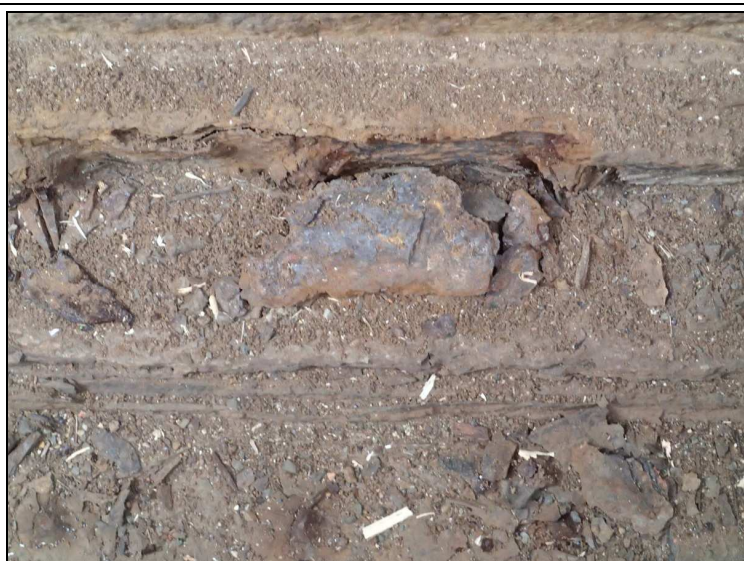
Foto č. 3 – konstrukce K 04 – hlavní nosník vlevo – 5. pole – dolní krční úhelník – koroze
