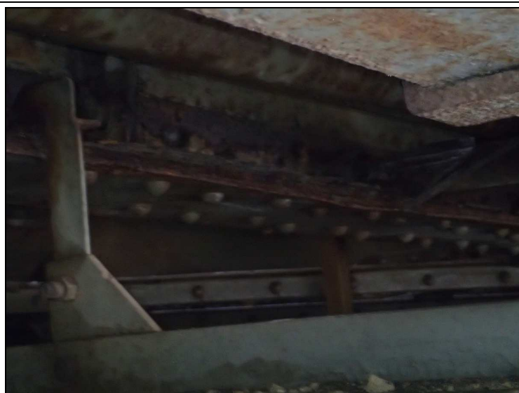
Foto č. 2 – konstrukce K 02 – dolní pásnice hlavního nosníku vlevo – plátková koroze
