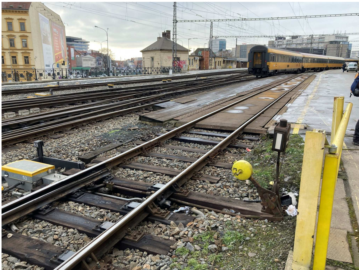
Obrázek 30 Pohled na přestavník výhybky a otočnou závoru za závěrnou zídkou opěry OP2
