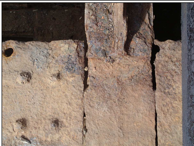
Foto č. 5 – konstrukce K 06 – 3. příčník – horní pásnice – koroze
