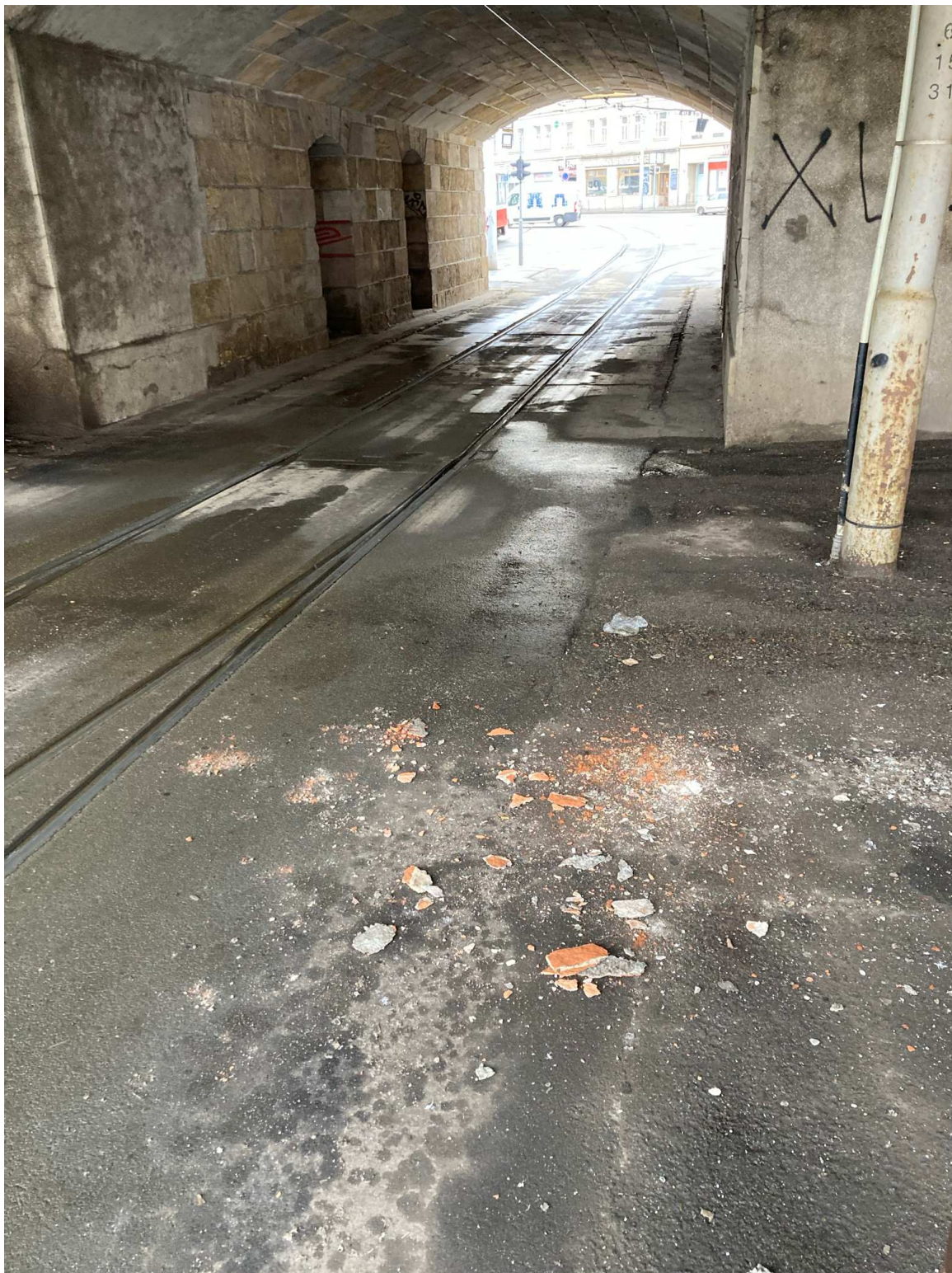
Obrázek 14 Opadávání degradovaných cihelných kleneb
