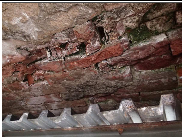
Foto č. 1 – konstrukce K 01 – nad P 01 – vydrolení cihelného zdiva v klenbě a průsak vody
