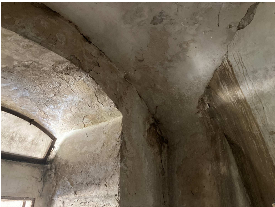
Obrázek 10 Sklepní prostory výpravní budovy v opěře OP1 pod úložným prahem vnitřní (železniční) konstrukce – patrné známky zatékání
