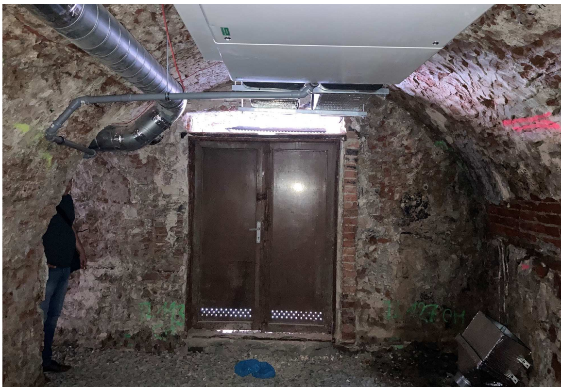
Obrázek 9 Sklepní prostory výpravní budovy v opěře OP1 pod vnější konstrukcí s novými rozvody vzduchotechniky
