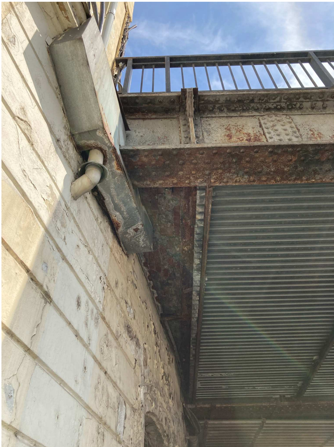
Obrázek 18 Uložení vnějšího nosníku ve stěně budovy (OP2) a oplechování odvodnění a kabelového vedení
