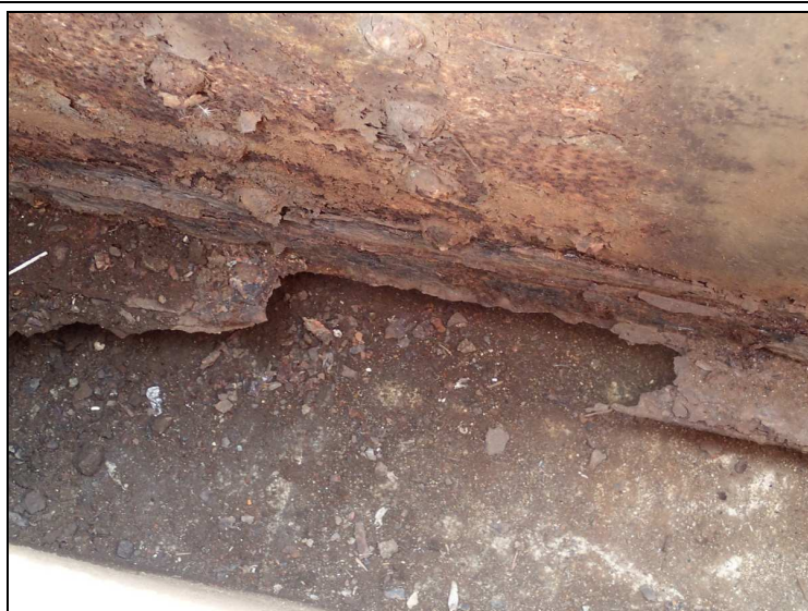
Foto č. 6 – konstrukce K 06 – 4. příčník – dolní pásnice – urezlá
