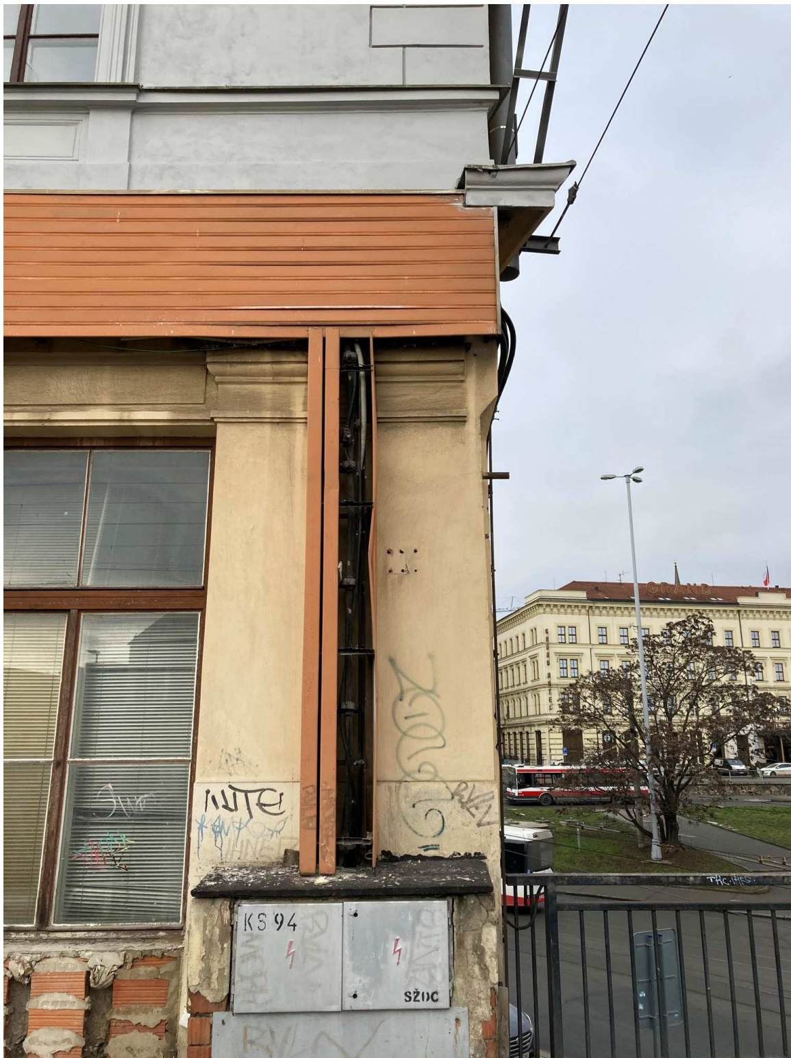
Obrázek 23 Pohled na nároží výpravní budovy nad vnějším nosníkem na OP1 – kabelová skříň a kabelová vedení
