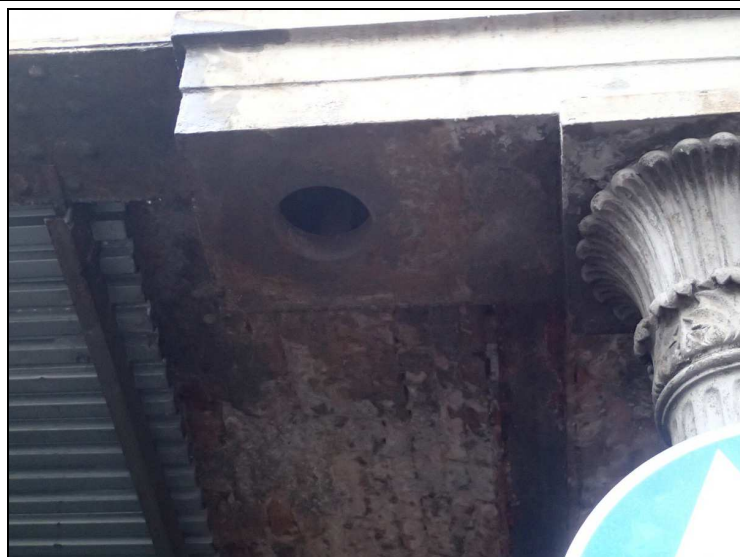
Foto č. 8 – pilíř P 01 – pod K 03 v otvoru 2 vlevo – chybí sloup pilíře
