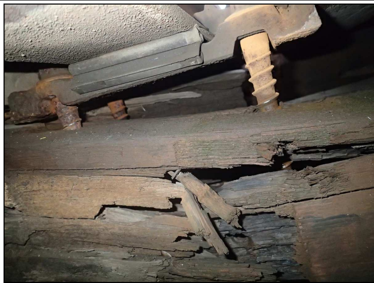
Foto č. 10 – konstrukce K 04 – mostnice č. 13 vlevo – prohnílá a prolomená pod podkladnicí
