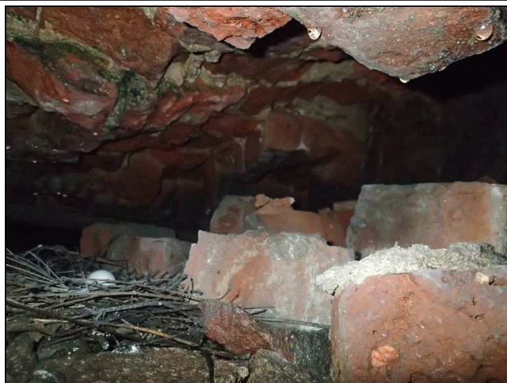
Foto č. 5 – konstrukce K 05 – nad P 05 – vydrolení cihelného zdiva v klenbě a průsak vody
