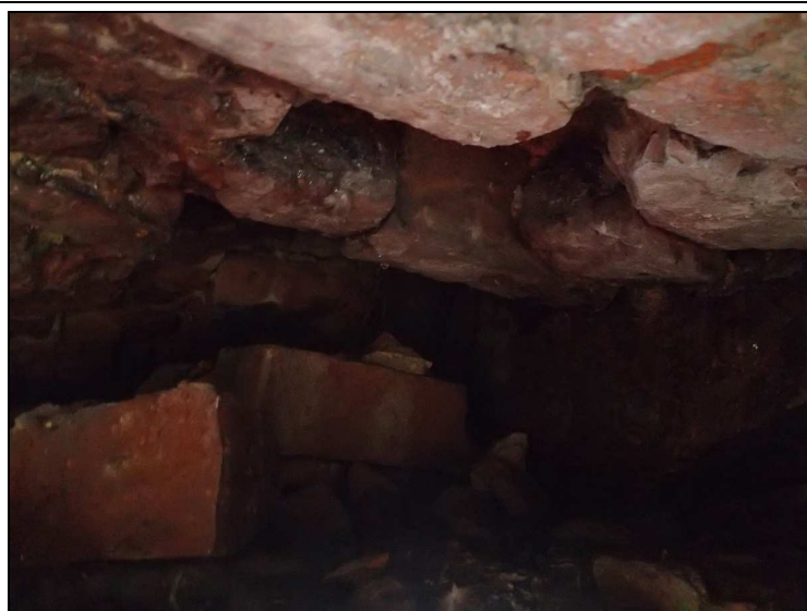
Foto č. 3 – konstrukce K 03 – nad P 05 – vydrolení cihelného zdiva v klenbě a průsak vody
