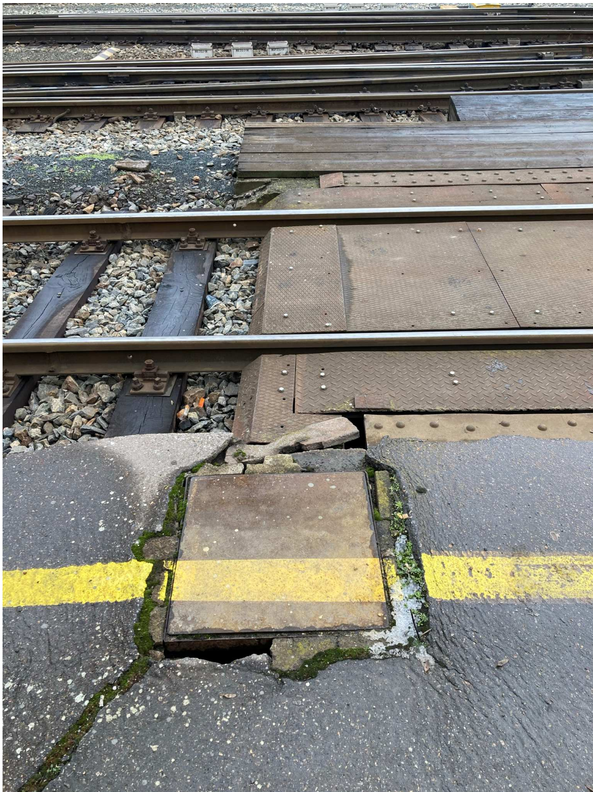
Obrázek 28 Kabelová šachta u závěrné zídky OP2
