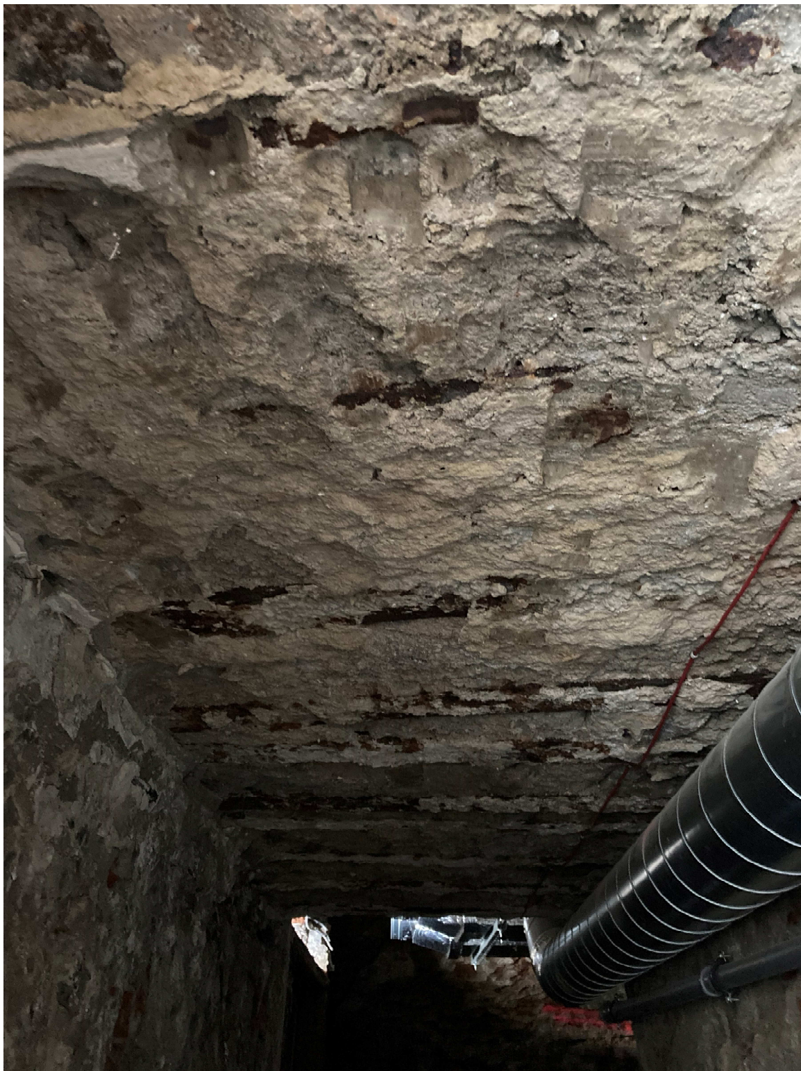
Obrázek 8 Sklepní prostory výpravní budovy – strop ze zabetonovaných kolejnic a nové vedení vzduchotechniky
