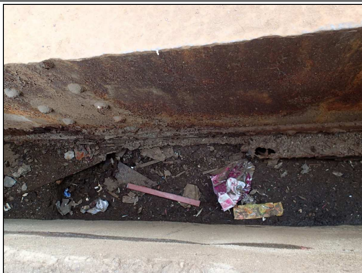
Foto č. 1 – konstrukce K 02 – 1. příčník – dolní pásnice – urezlá
