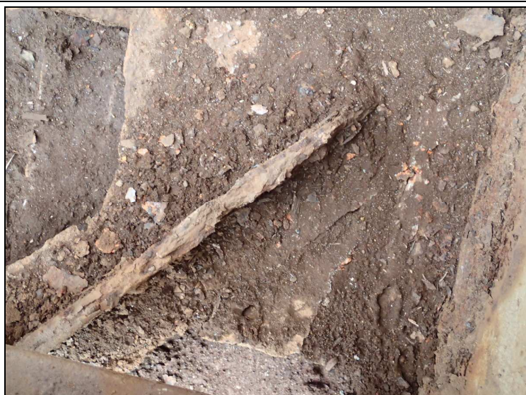
Foto č. 2 – konstrukce K 02 – styčnickový plech nad O 01 vpravo – koroze
