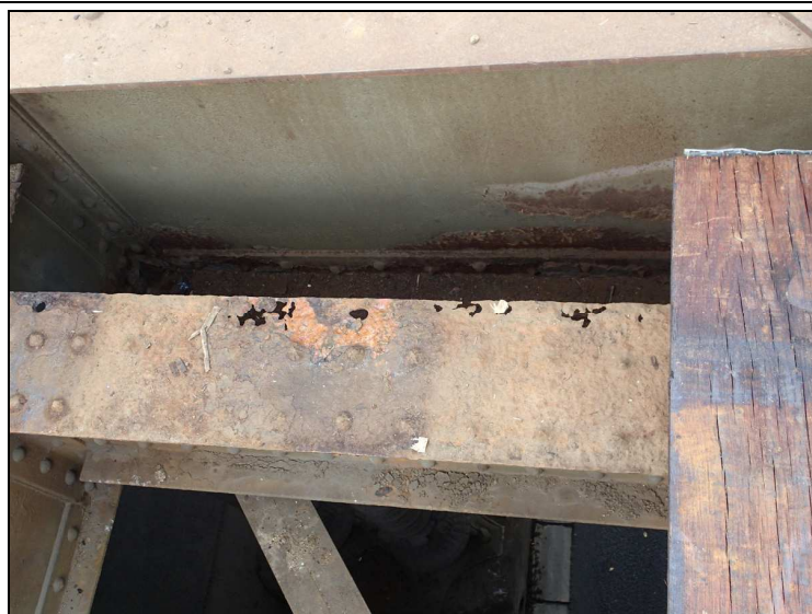
Foto č. 4 – konstrukce K 04 – podélník vlevo – 1. pole – koroze horní pásnice
