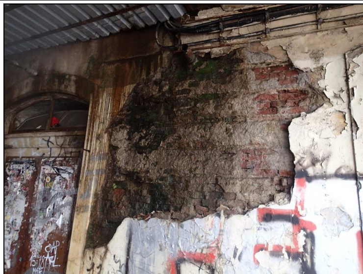
Foto č. 7 – opěra O 01 – pod K 02 – silný průsak vody
