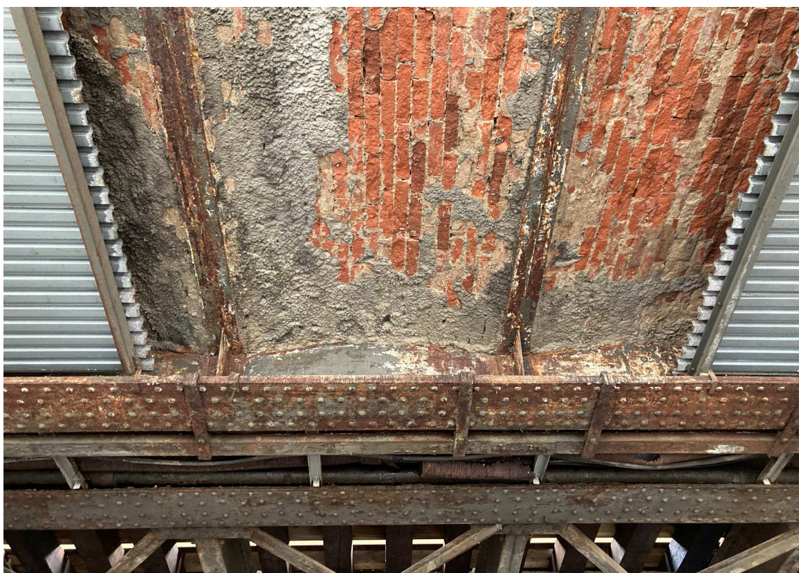
Obrázek 13 Pohled zespodu na vnější konstrukci mezi 3. a 4. mostním otvorem – ploché cihelné klenby
